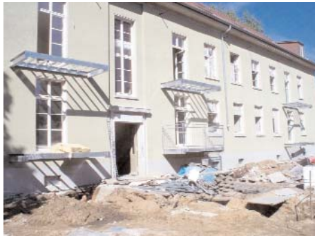
Bauprojekt in Karlshorst.
